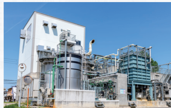
脱水分離液処理施設全景
