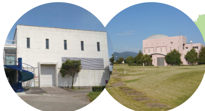
昆陽川捷水路排水機場
