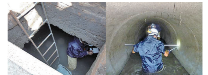
事業対象管渠の詳細調査
