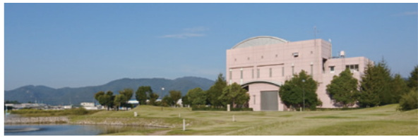
山陽浄化センター
